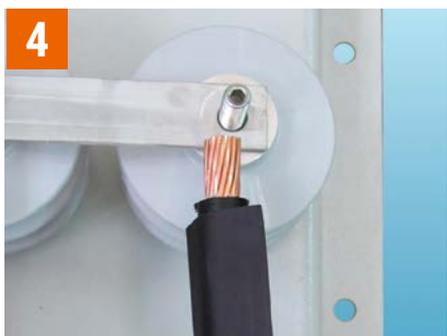
Шаг 4. Надеть на ППС термоусаживаемую трубку (ТУТ), далее обжать наконечник на разделанном конце провода ППС.
