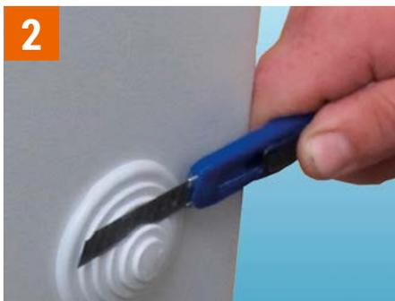
Шаг 2. На нижней панели ножом срезать силиконовый сальник на диаметр, который соответствует диаметру провода ППС.
