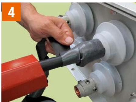
Шаг 4. Обмотать провод ППС при помощи «скотча 23» в два слоя, начиная от юбки проходного изолятора.
