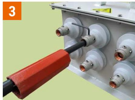
Шаг 3. Защищенный конец ППС вставить в проходной изолятор и затянуть винты при помощи торцевого ключа-шестигранника.
