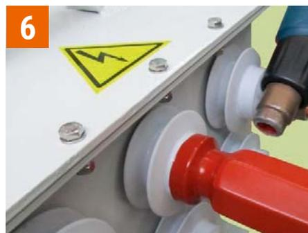
Шаг 6. Выполнить термоусадку трубки «термофит» при помощи термопистолета или газовой горелки, начиная от юбки проходного изолятора.
