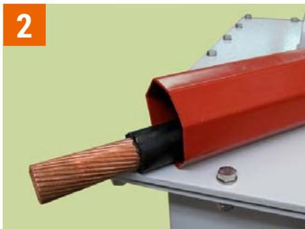
Шаг 2. Разделать провод ППС, сняв с него изоляцию на необходимую длину, затем одеть термоусаживаемую трубку «термофит».
