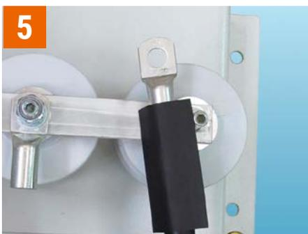
Шаг 5. Надеть наконечник на шпильку ОПН и закрепить гайкой, после чего подвергнуть трубку термоусадке термопистолетом или газовой горелкой.
