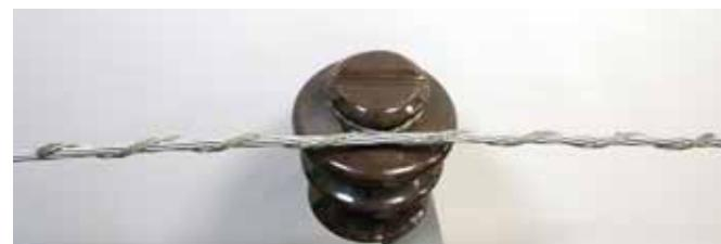
Рис. 2. Крепление провода с применением одиночной вязки на штыревых изоляторах
