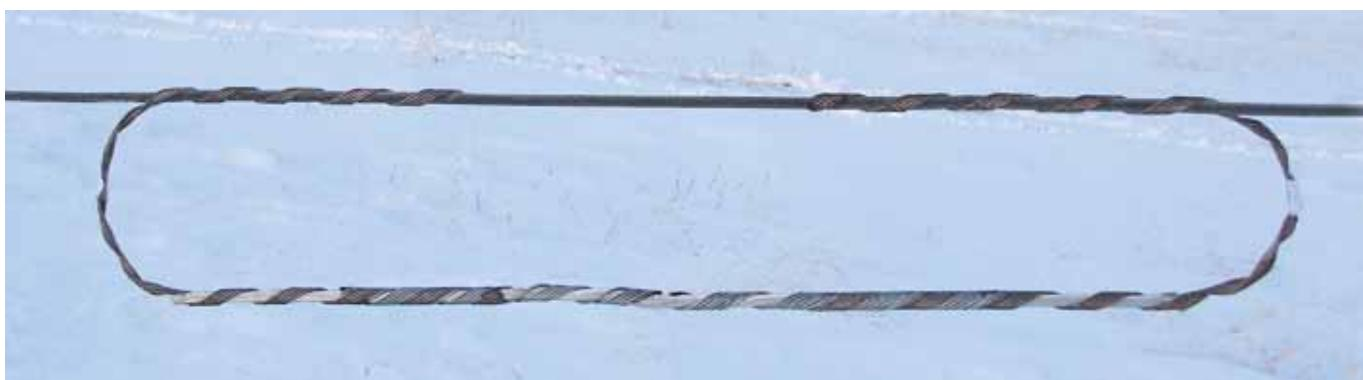
Рис. 5. Однопетлевой гаситель пляски «Крыло» на проводе АС-120/19
