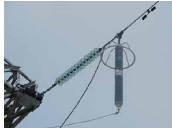
На сегодняшний день подвес ограничителей перенапряжения с использованием защитных протекторов ЗАО «ЭССП» реализован на линиях ВЛ-220 кВ «Уренгой–Надым», ВЛ-220 кВ «Уренгой–Пангуды», ВЛ-220 кВ «Пангуды–Надым» (спецпереход через р. Надым).
