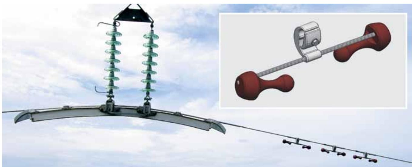
Рис. 11. Гасители вибрации марки ГВ-4433-02 на переходе
