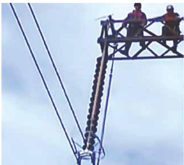
Захват за провода фазы может осуществляться с помощью подхвата 1160.00.00.000 (ТУ 5221-130-27560230-13). При сочленении с балками полимерными изоляторами работы могут проводиться без отключения линии. Для доставки монтера к фазе в этом случае целесообразно использовать сиденье 13462.00.00.000.
