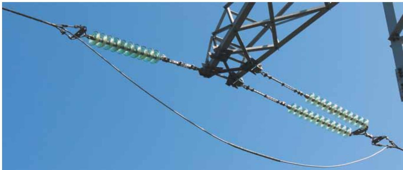
Зажимы соединительные шлейфовые спиральные типа ШС-Дпр-ХХ (ТУ 3449-036-27560230-06) предназначены для соединения стальалюминиевых проводов по ГОСТ 839 в шлейфах воздушных линий электропередачи.
