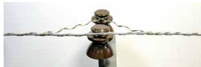
Рис. 5. Крепление провода к двум изоляторам боковыми вязками
