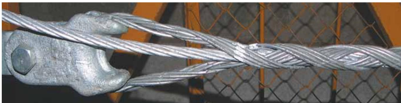
Рис. 4. Натяжной зажим HC-13,0-31(200)-M3 в смонтированном виде
