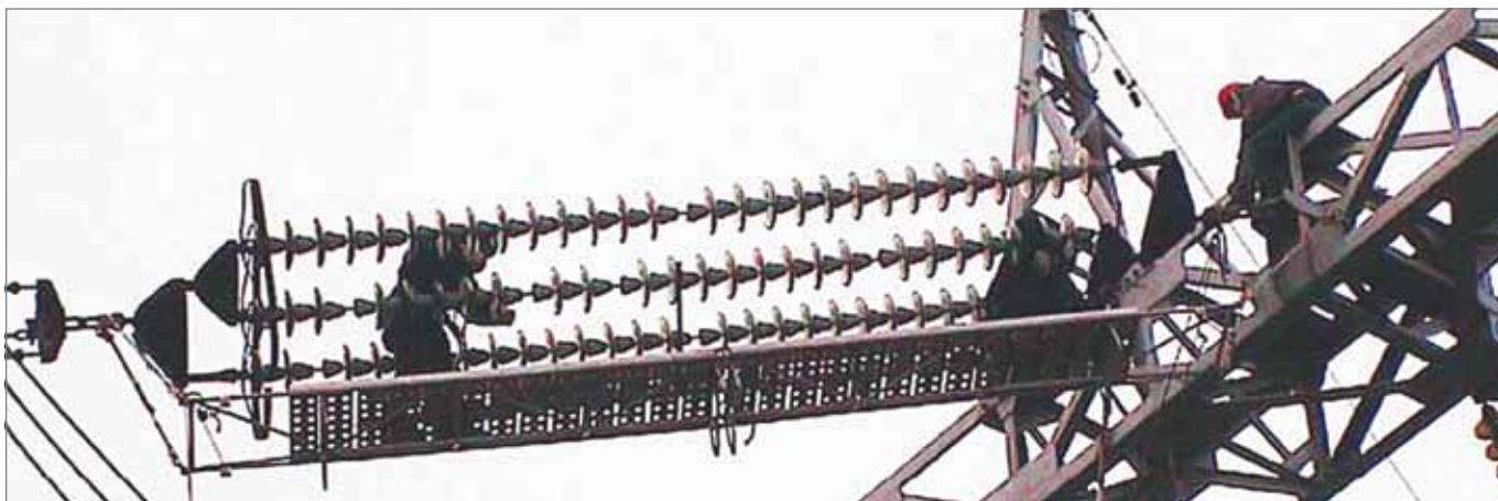
Грузоподъемность трапа любой модификации — не более 250 кг.
