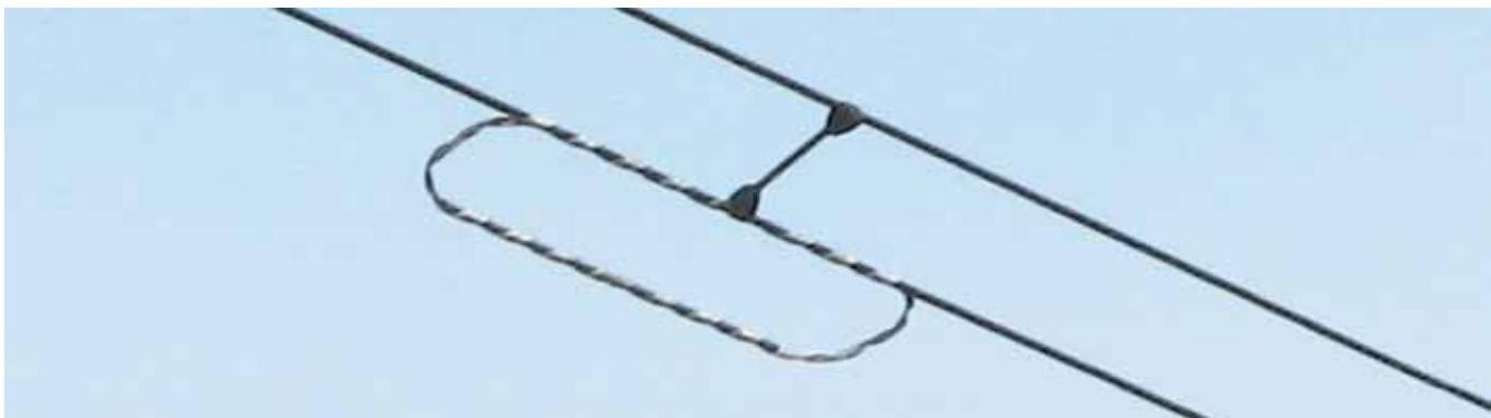
Рис. 7. Гаситель пляски ГПС-24,0/24,5-02-21 «Крыло», смонтированный на ВЛ 330 кВ
