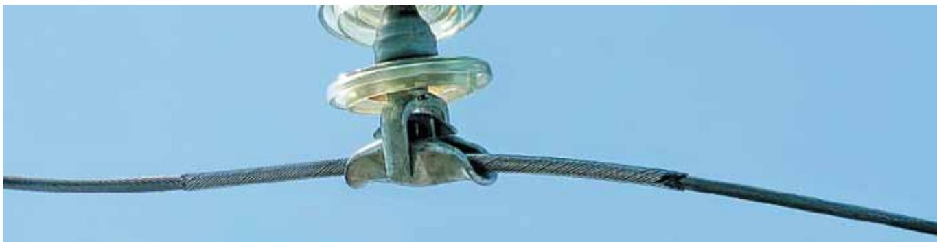
Протекторы защитные спиральные типа ПЗС (ТУ 3449-007-27560230-06) предназначены для дополнительной защиты проводов и грозозащитных тросов от вибрации в поддерживающих и соединительных зажимах, многороликовых подвесах на переходах ВЛ, а также алюминиевых полых проводов типа ПА в аппаратных зажимах.
