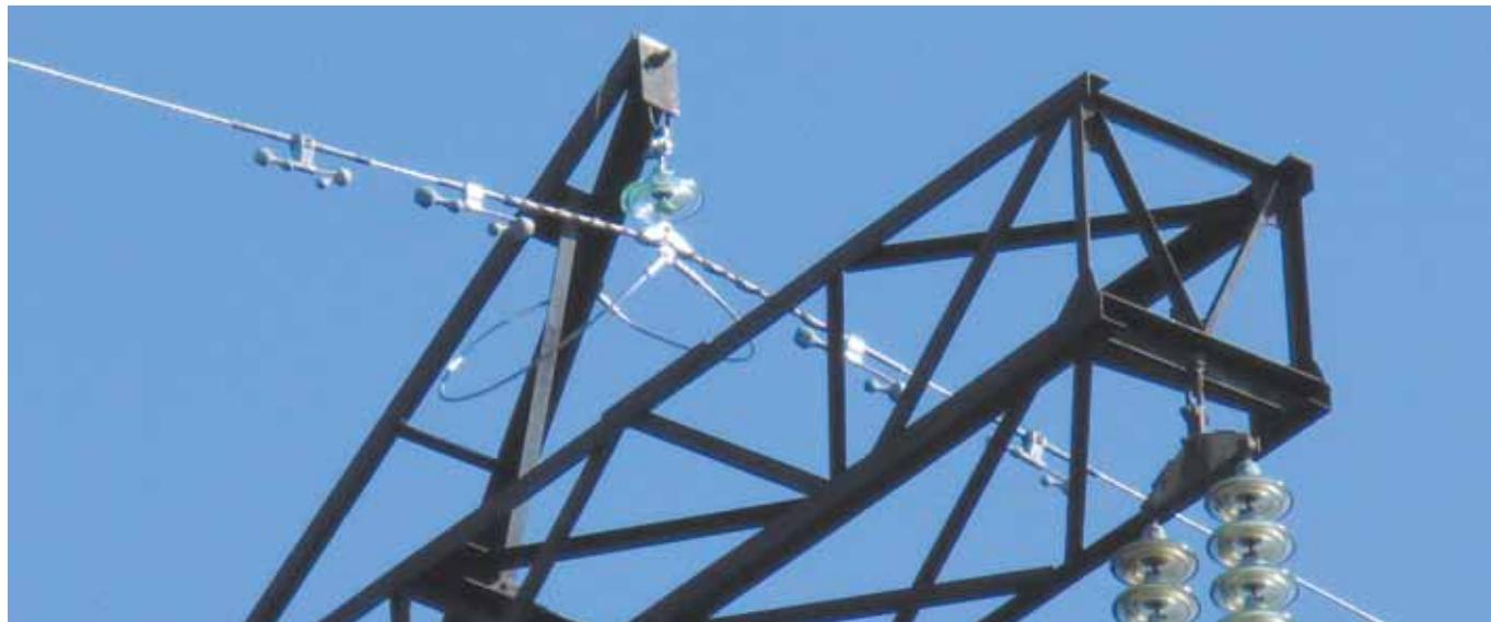
Зажимы соединительные шлейфовые спиральные типа ШС-Дтр-11 (ТУ 3449-036-27560230-06) предназначены для соединения грозозащитных тросов по ГОСТ 3062, ГОСТ 3063, ГОСТ 3064, СТО 71915393-ТУ 062-2008 в шлейфах воздушных линий электропередачи.
