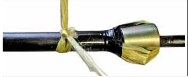
**7.4** Зафиксировать узлы нитей, наложив поверх них ленту ПВХ. Ленту 2900R разрезать вдоль на две части и поочередно намотать на внутреннюю оболочку возле конуса, заводя ленту под конус.
