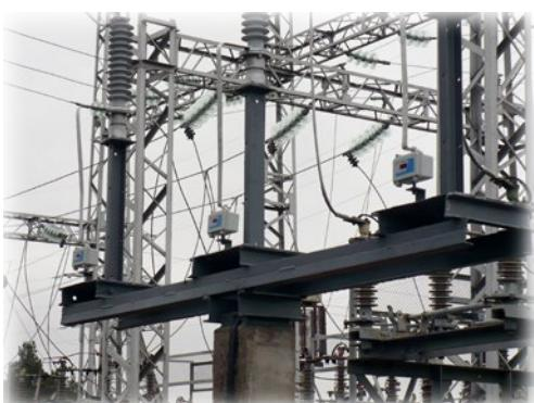
Прибор ИТУС-1 (Рис.63-1) предназначен для комплексного контроля состояния ОПН под рабочим напряжением. С помощью прибора производится измерение параметров тока проводимости, протекающего через ОПН при рабочем напряжении: действующих значений гармонических составляющих тока 50 Гц и 150 Гц и максимального значения тока, а также регистрация импульсов тока проходящих через ОПН (регистрация срабатывания).
